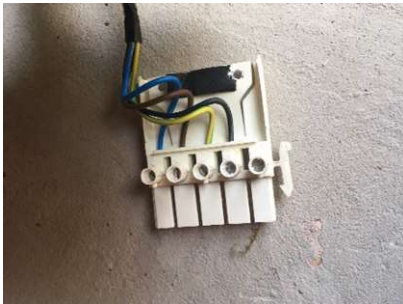
Vanha 5-nap. EnstoNet-liitin puhaltimessa Äldre 5-pol. EnstoNet-kontakt i fläkten
